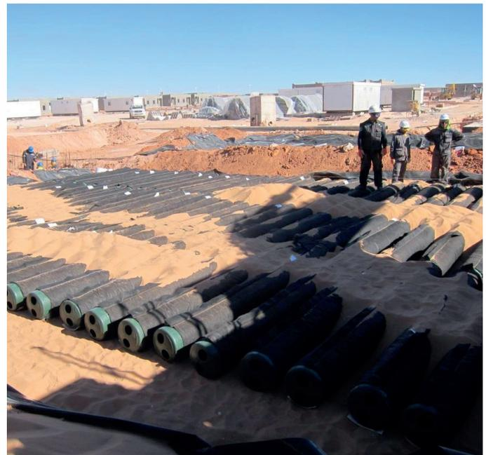
Base de vie de Krechba – Les travaux de recouvrement des conduites Advanced Enviro))Septic avec du sable filtrant
