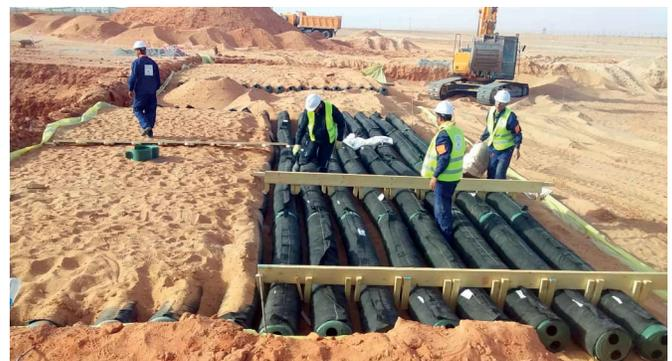
Les conduites à moitié recouvertes par du sable filtrant
