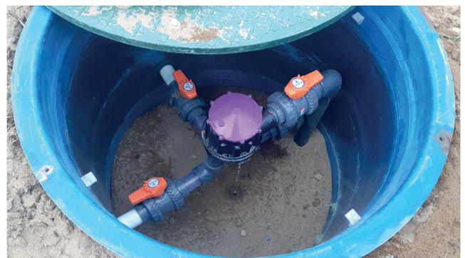
Chambre à vanne rotative qui distribue par alternance aux différentes cellules System O))
