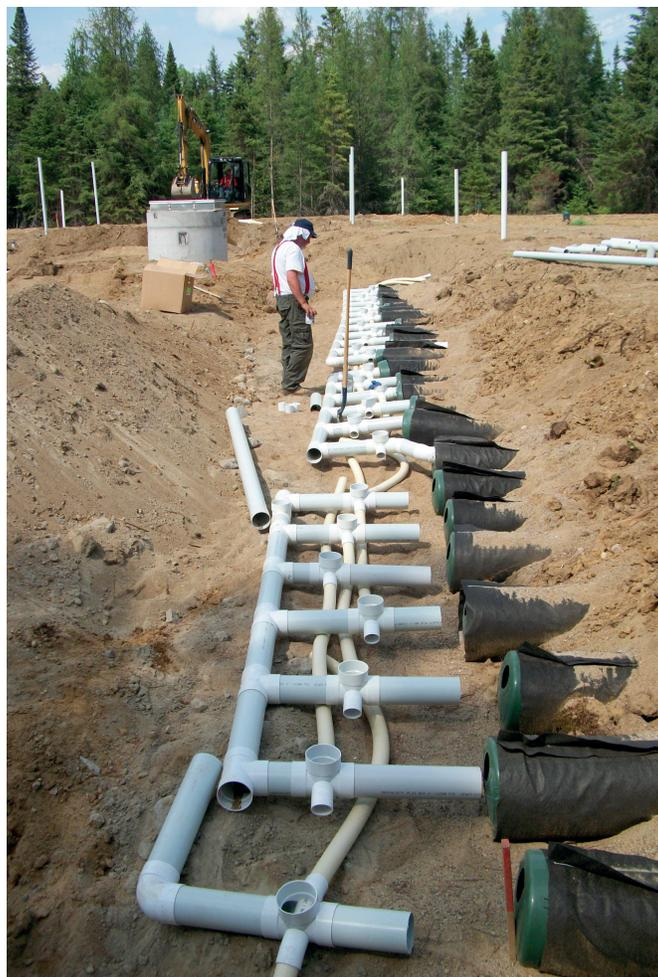
Raccorder les têtes du système de répartition à faible pression
