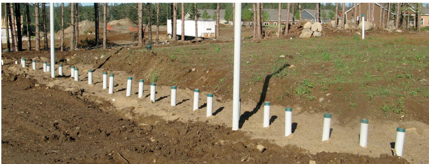
La ventilation et les têtes du système de répartition à faible pression
