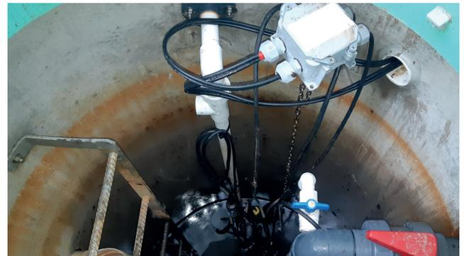
Estación de bombeo que alimenta los inyectores a baja presión
