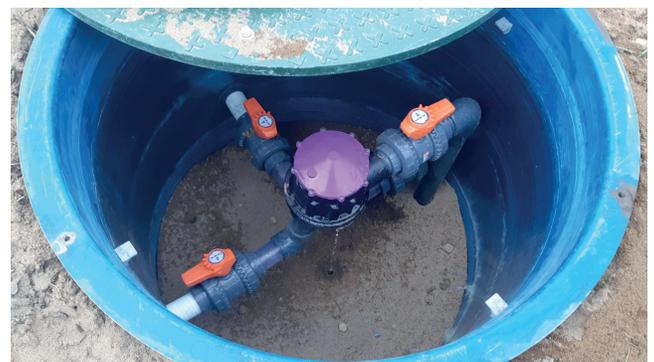
Cámara de válvula rotativa que se distribuye alternativamente a las diferentes celdas del System O))
