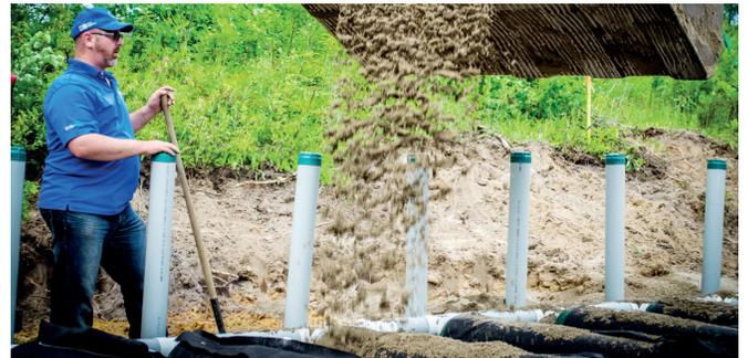
Los piezómetros se utilizan para medir la altura del agua en el interior de cada conducto y para garantizar la distribución uniforme de las aguas residuales
