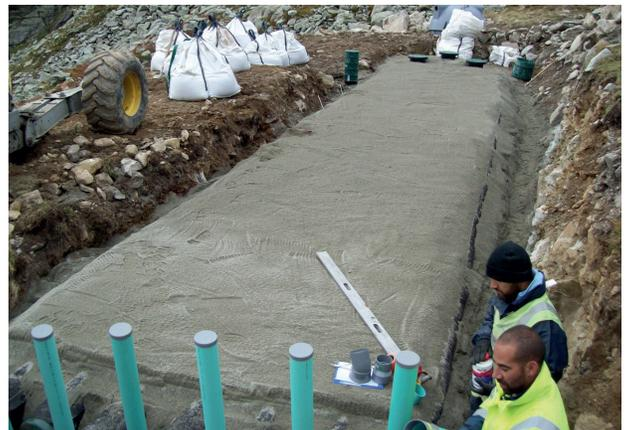
Cubrir la instalación System O)) con arena filtrante
