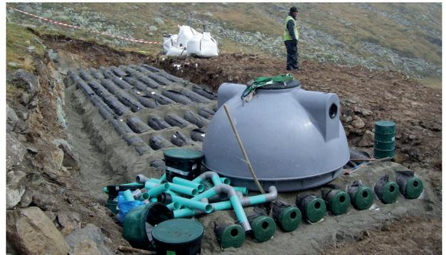
Disposición de los componentes del sistema séptico
