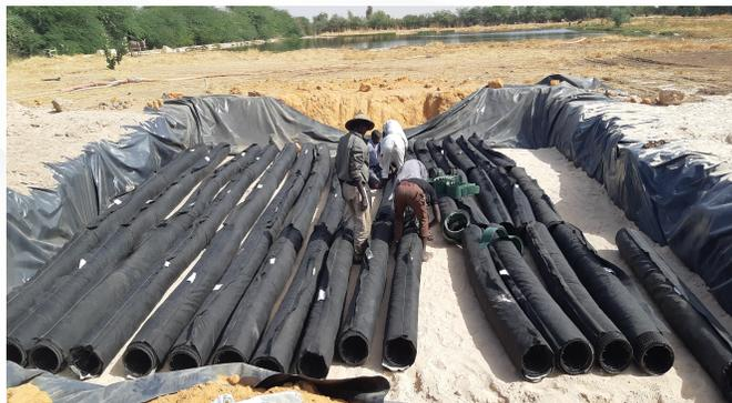
Conectar todas las tuberías de Advanced Enviro))Septic a la membrana impermeable
