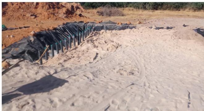
Los piezómetros, la ventilación y la arena filtrante que cubren las tuberías de Advanced Enviro))Septic
