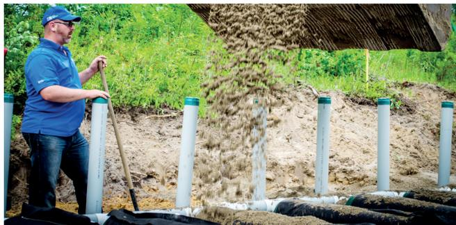
Les piézomètres permettent de mesurer la hauteur de l'eau à l'intérieur de chaque conduite et s'assurer de la distribution uniforme de l'eau usée.
