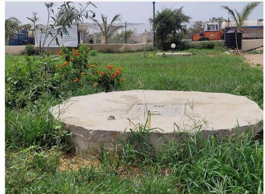
Réservoirs de 3000L l'un servant de fosse septique et l'autre de bassin de stockage des eaux traitées
