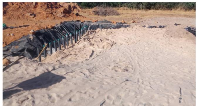
Les piézovents, la ventilation et le sable filtrant recouvrant les conduites Advanced Enviro))Septic
