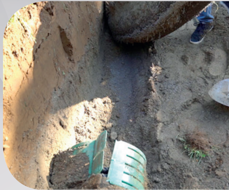
Système installé en 2004, inspecté en 2019
