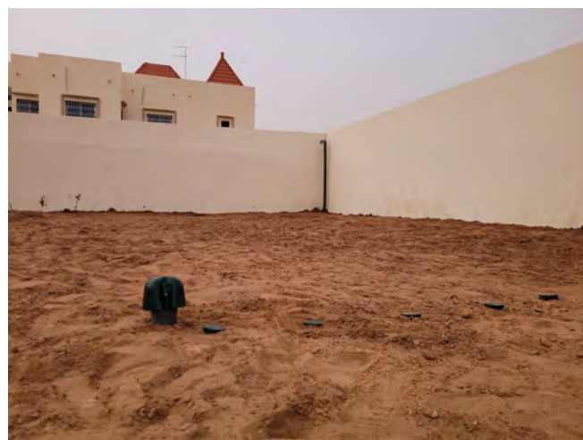
Installation System O)) terminée
